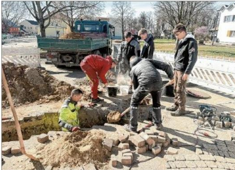
Na Worklečanskim šulskim dworje su wčera za wjesny młodžinski klub nowy wopłóčkowy kanal kładli. Wječor bě wšo hotowe.
